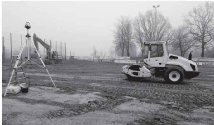
Abgeschoben: Mit Baggern wird der Untergrund des Sportplatzes erneuert. Der alte Unterbau hielt den Belastungen nicht stand.
